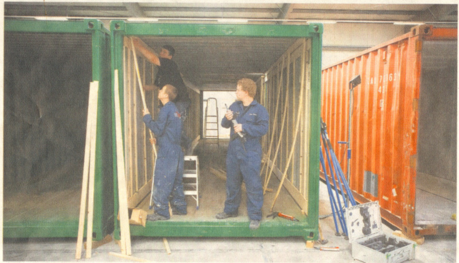
De fabriek aan de Cruquiusweg waar jongeren met leerachterstanden woningen van containers maken.
