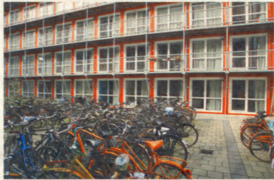
À Bijlmermeer, dans le sud de la ville. Les caissons de 30 m 3 sont empilés sur cinq étages.
