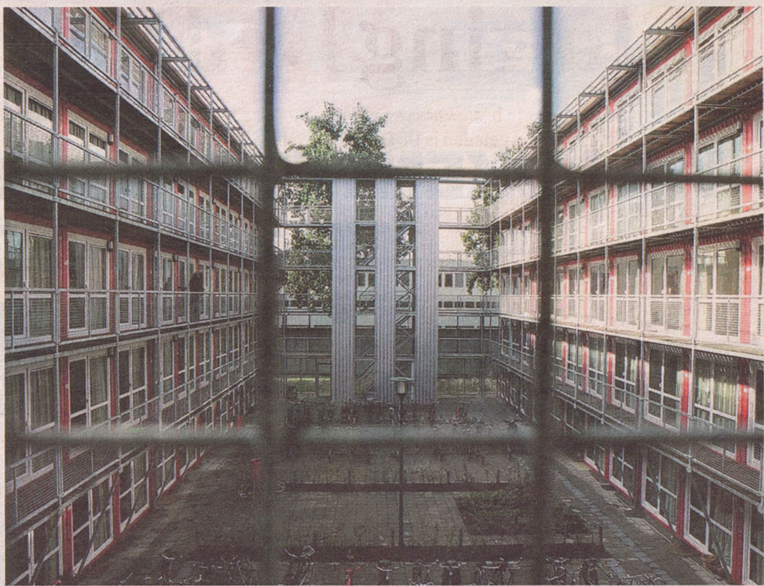
Het complex met studentenwoningen in container aan de HJA Wenckebachweg. FOTO'S GEERT SNOEIJER
