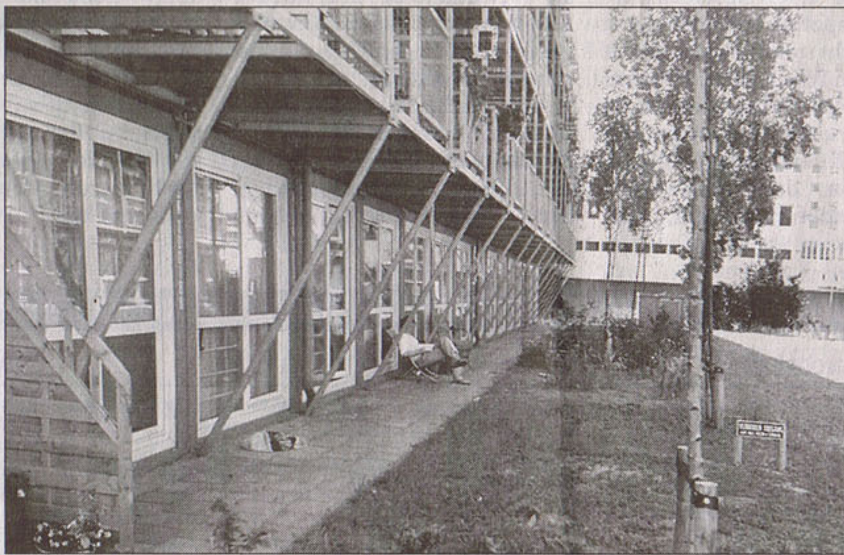
Ein Idyll aus Blech: Das Studenten-Containerdorf in Amsterdam FOTO: TEMPOHOUSING
